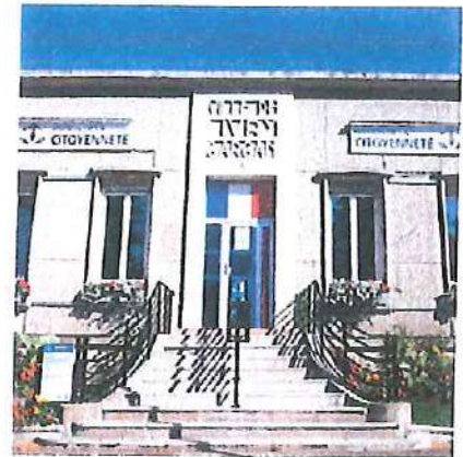
Travaux d'aménagement à la Maison de la citoyenneté
