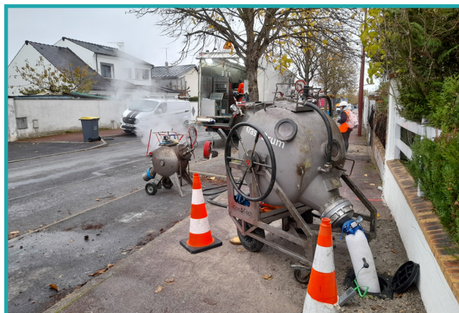
Exemple d'une opération de réhabilitation du réseau d'assainissement des eaux usées et pluviales, avenue Daniel Perdrigé à Montfermeil.
