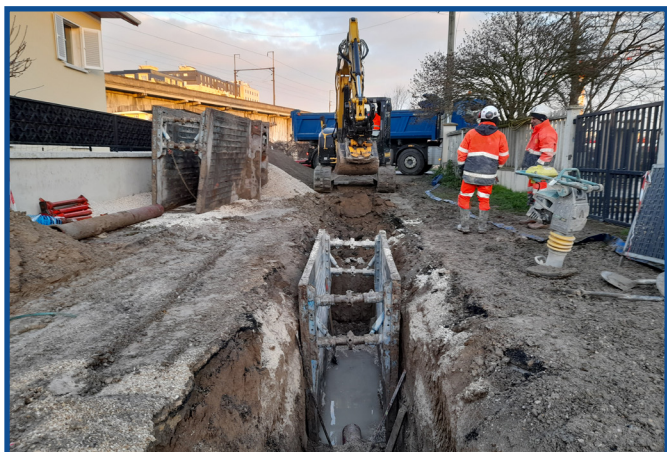
Pour limiter les rejets d'eaux usées dans les milieux naturels, les équipes assainissement de Grand Paris Grand Est travaillent à la création et à la réhabilitation de réseaux sur tout le territoire.
